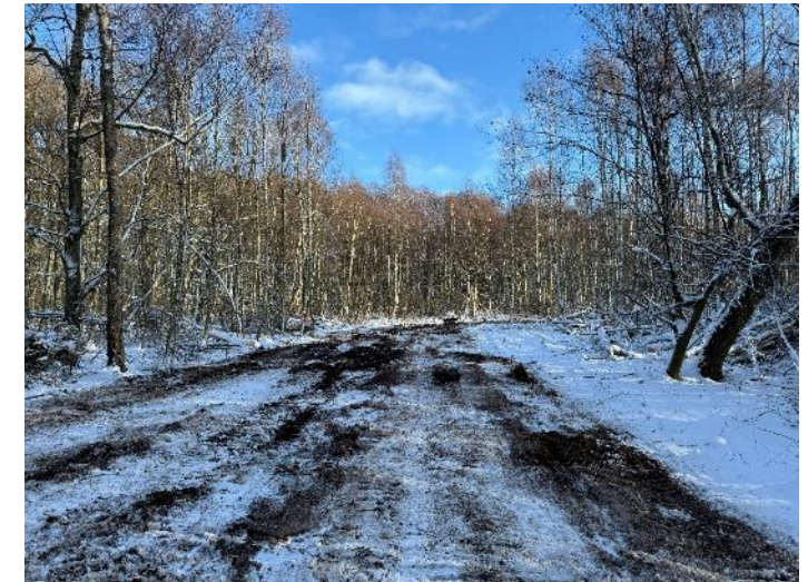
Freigestellte Trasse am 31.01.2024- Bereich C
